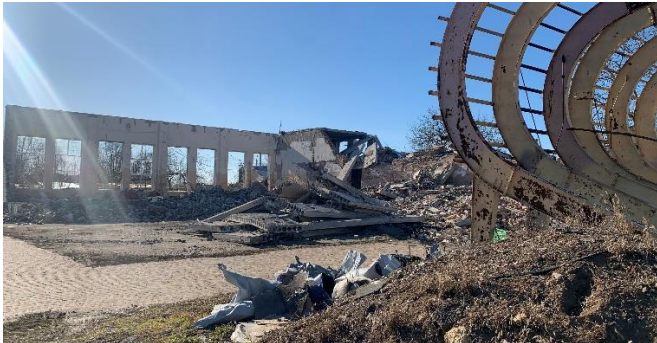
Zerstörtes Freizeitzentrum mit Turnhalle und Schwimmbad, Sportanlage mit Duschen/Kabinen
