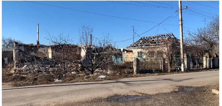
Zerstörte Wohnhäuser durch direkten Bombentreffer
